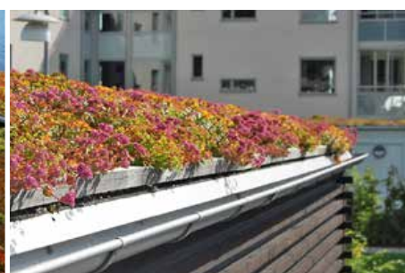
Detaljer vid takfot Närbild på takfot med fotplåt och kantavslut med eklist i rostfritt stål.
